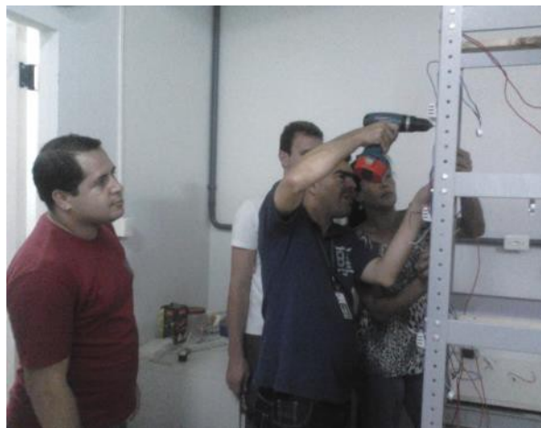
Figura 4: Montagem do sistema de recirculação.
